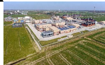
Gasspeicher Nüstermoor 21 Kavernen
